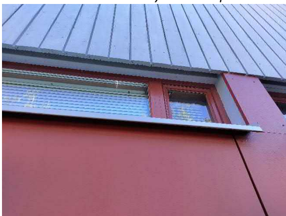
Sisäpihan puolen julkisivuissa levytys
