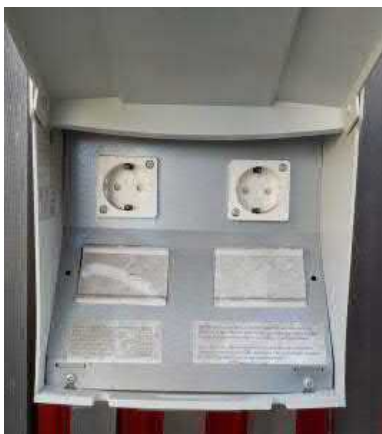
Pelastusajoneuvon sähköistykseen tarkoitettu kotelo ilman ohjauksia
