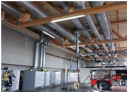
Kalustohallin ilmanvaihtokanavistoa.
