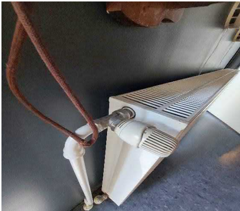
Patteriventtiili ja termostaatti.
