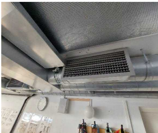
Poistoilmasäleikkö kuntosalitiloissa.
