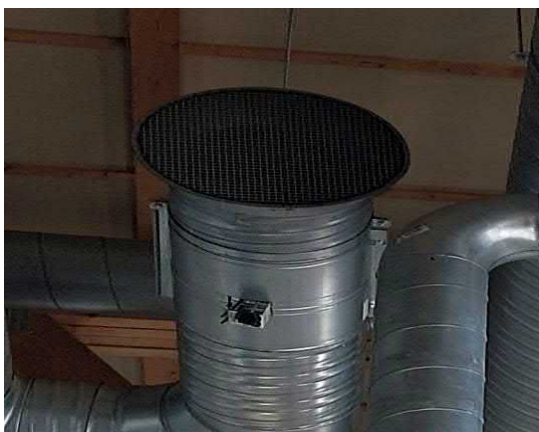
Poistoilma-imukartio autohallissa.
