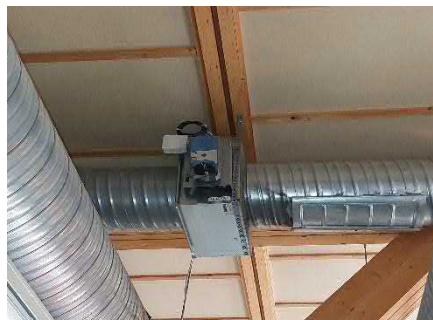
Toimilaitteella varustettu sulkupelti.
