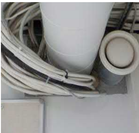
Kaapelien läpivientiä IV-kanavan vieressä
