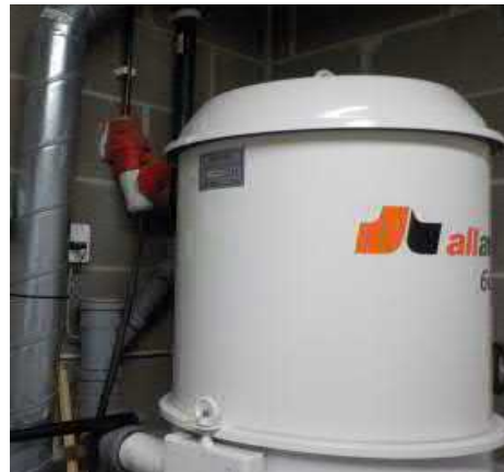
Keskuspölyimurin sähköistystä varastossa
