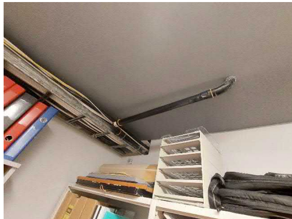
Keskuspölynimurijärjestelmän imuputkistoa.
