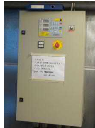
Varavoimalaitteiston ohjauskeskus
