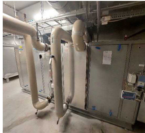
Ilmanvaihtokoneen jälkilämmityspatteri.
