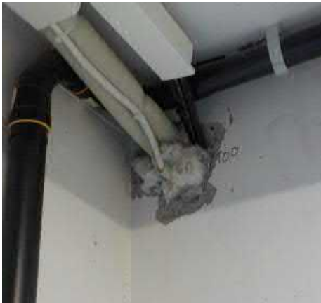
Kaapelien läpivientiä seinässä
