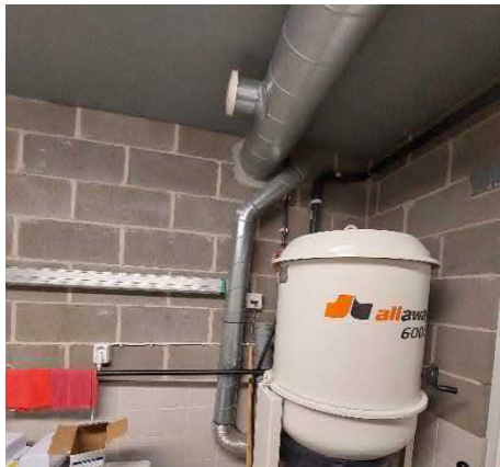
Keskuspölynimurijärjestelmän keskusyksikkö.
