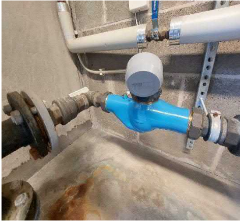
Kiinteistön päävesimittari.
