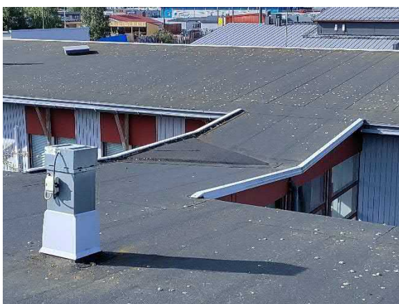
Yleiskuva toimisto-osan vesikatolta
