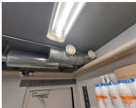
Poistoilmaventtiilit varastossa.
