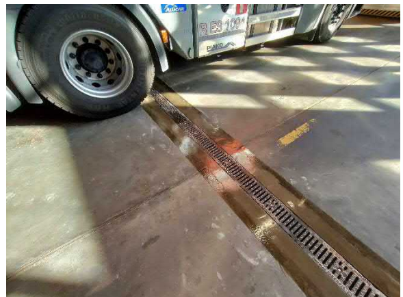
Hallin lattia on osittain uusittu
