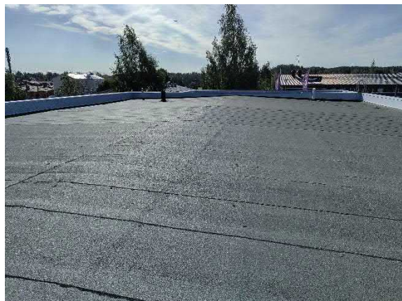
Yleiskuva halliosan vesikatolta
