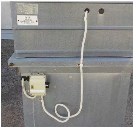
Huippuimurin sähköistystä vesikatolla
