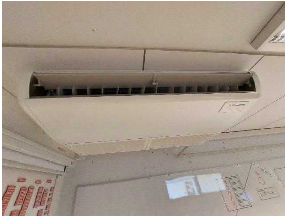
Jäähdytysjärjestelmän sisäyksikkö.
