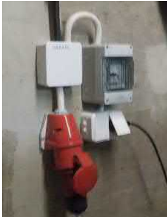
Pistorasioita ja niiden haaroituskotelo
