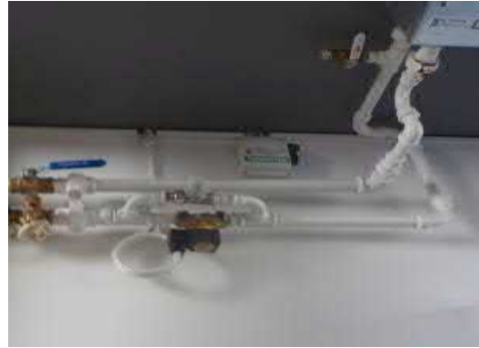
Kiertoilmakojeen sähköistystä tuulikaapissa
