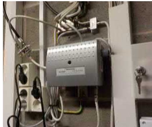
Antennivahvistin ja -jaottimia teletilassa
