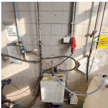
Pesuaineen levitysjärjestelmä pesuhallissa.
