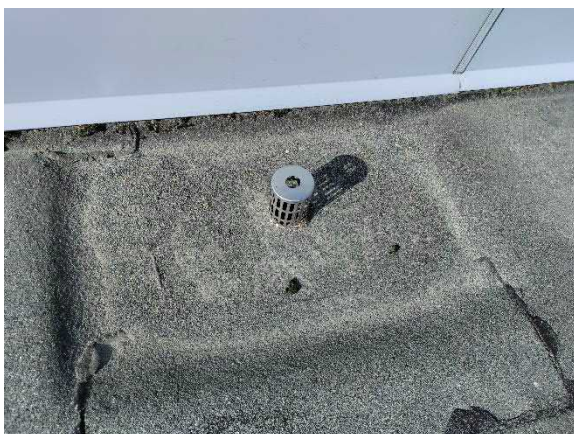
Kattokaivot ovat puhtaita
