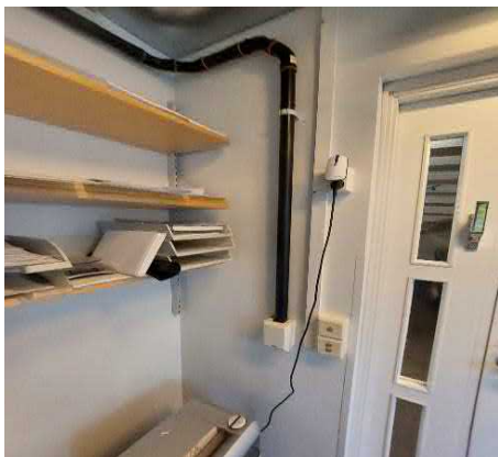
Keskuspölynimurijärjestelmän imurasia.
