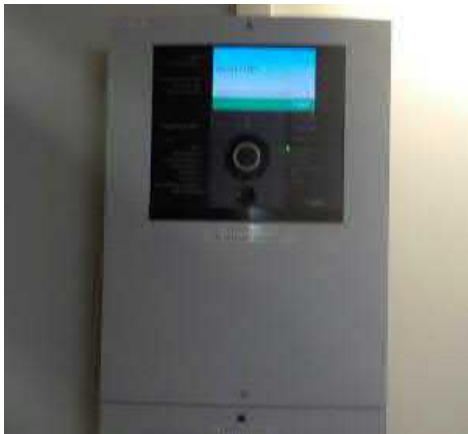
Uusittu palovaroitinkeskus
