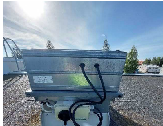
TK03PF02 poistoilmahuippuimuri.
