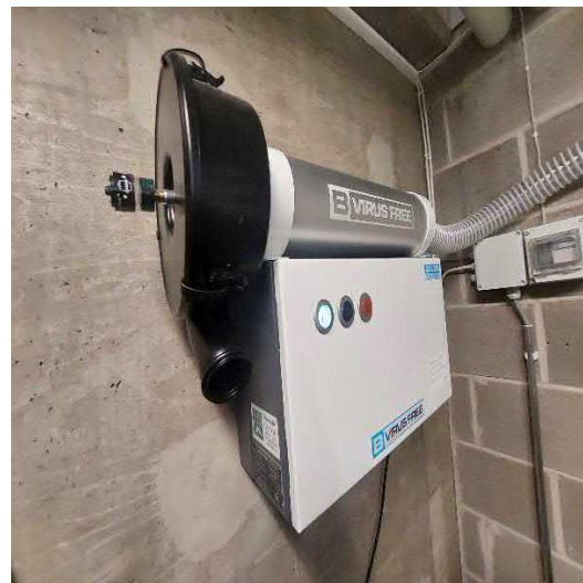
Hengityspaineilmajärjestelmän suodatin.
