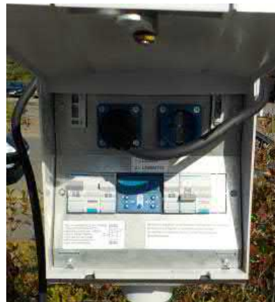
Ajoneuvon lämmityksen ja latauksen mahdollistava kotelo
